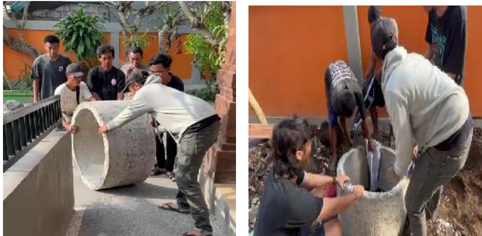
Gambar 7. Proses Pemasangan Buis Beton
