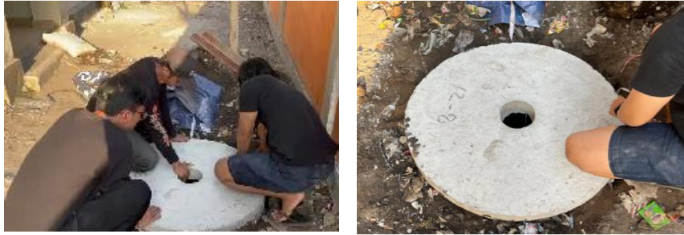
Gambar 8. Proses Pembuatan Lubang dan Pemasangan Tutup Buis
