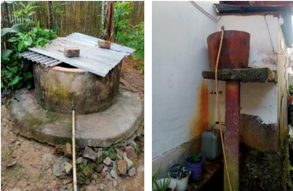
Gambar 1. Sumber Air Bersih dan Proses Saringan Sederhana Sumber : Dokumentasi Lapangan
